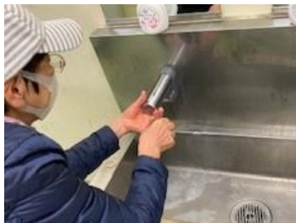
①センサー先端部のキャップを取り外す(引き抜く)。
