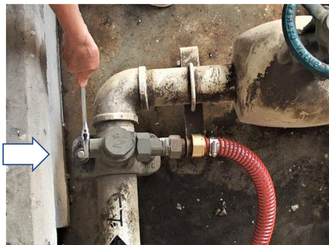
排水口のパルプを開ける。
