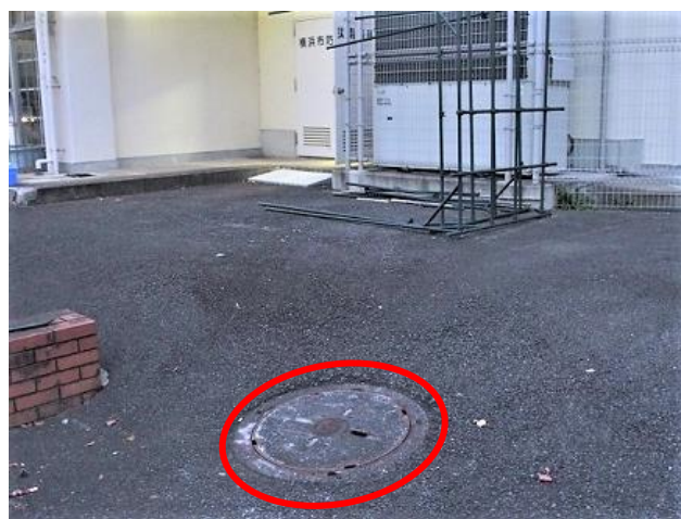
流末B；備蓄倉庫前
