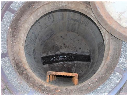
マンホール内部 (流末A)
