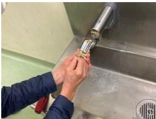
③電池パックを引き抜き、乾電池を取り外す。
