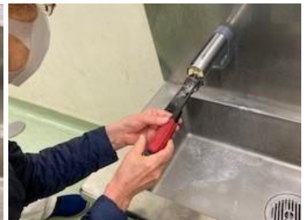
②電池パックの取付ネジを取り外す。
