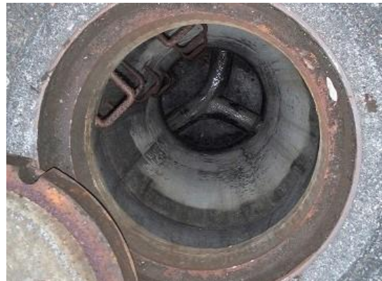
マンホール内部 (流末B)
