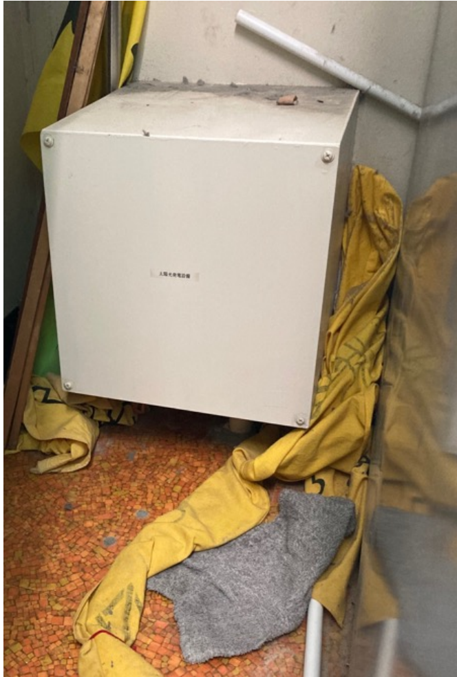
屋上出口階段部のボックス
