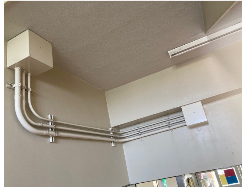
4階階段天井のボックス
